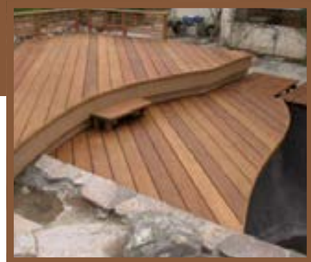
Deck feito em madeira tratada Tratore
