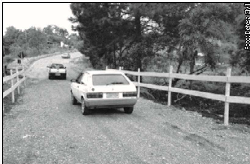
Obra foi parcialmente concluída e tráfego liberado em apenas 12 dias
