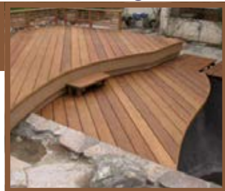
Deck feito em madeira tratada Tratore
