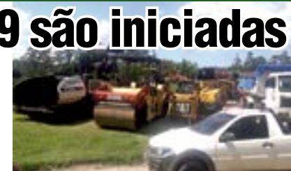
Máquinas e veículos estão sendo distribuídos pelo Município para obras na rodovia
