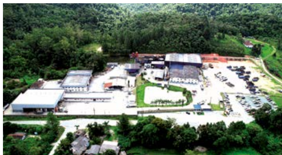
Planta industrial da Supply Service em Tapiraí
